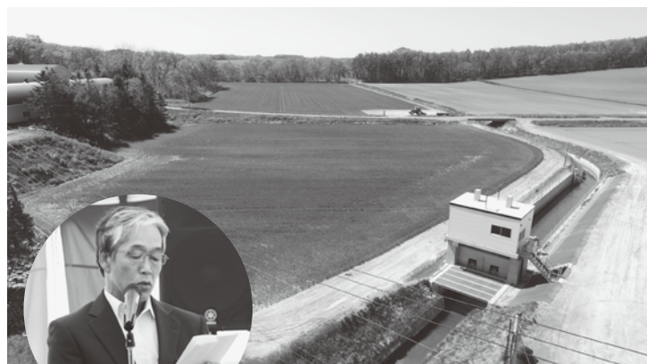
▲上:上空から見る排水路と排水機場
